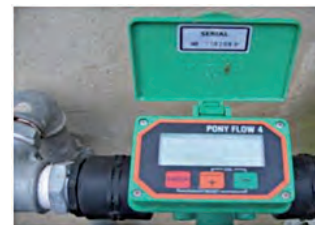
Photo 4 : compteur volumétrique électronique (G. Fiaux, 2007)
