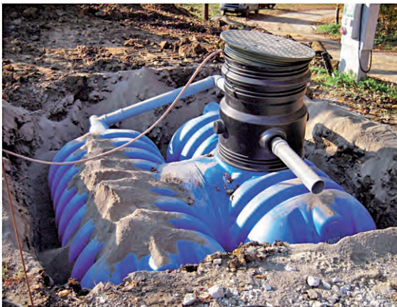
Photo 7: cuve enterrée avec double manteau (L. Chevalier).
